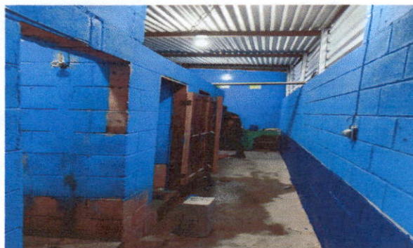
Foto 4: Vista de interior de sanitarios
