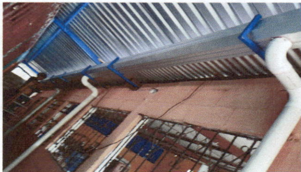
Foto1: Vista de canales de agua pluvial
