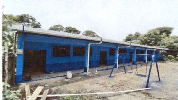
Foto 5: Vista frontal de canales para agua pluvial
