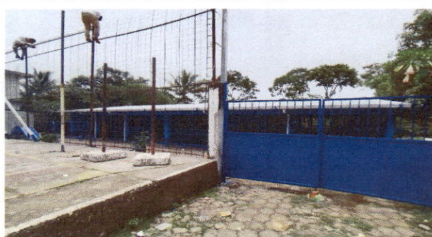
Foto 6: Vista de entrada principal del centro educativo
