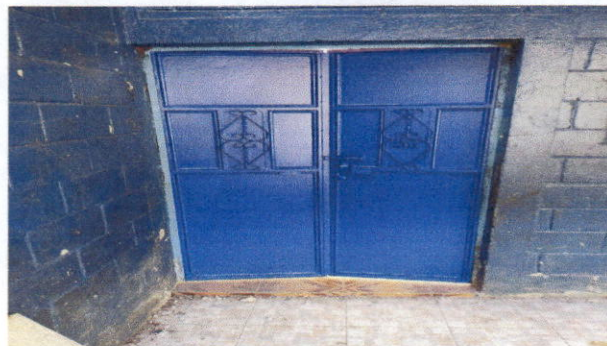
Foto 2: Vista frontal de puerta interior de aula
