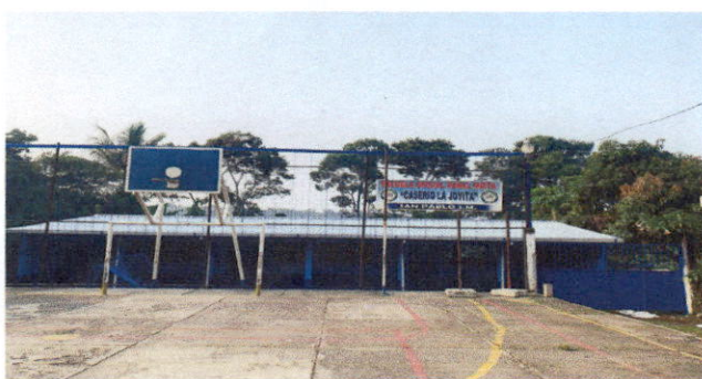
Foto 3: Vista frontal de aulas
